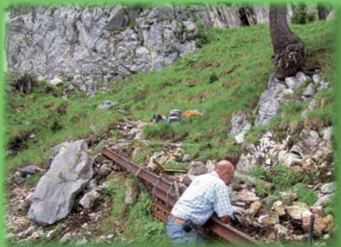
2012: Sanierung eines Elementarschadens am Dr.-Julius-Mayr-Weg
