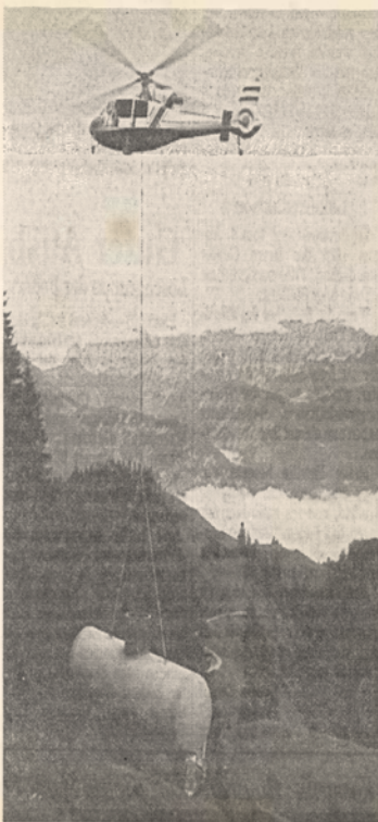
Auf dem Brünstein ratterten Baumaschinen: Die Wasserversorgung des DAV-Brünsteinhauses wurde erweitert und eine neue Kläranlage installiert. Der neue Wasserbehälter im Gewicht von 1,2 Tonnen wurde mit einem Hubschrauber auf den Berg gebracht. Foto: Seebacher
